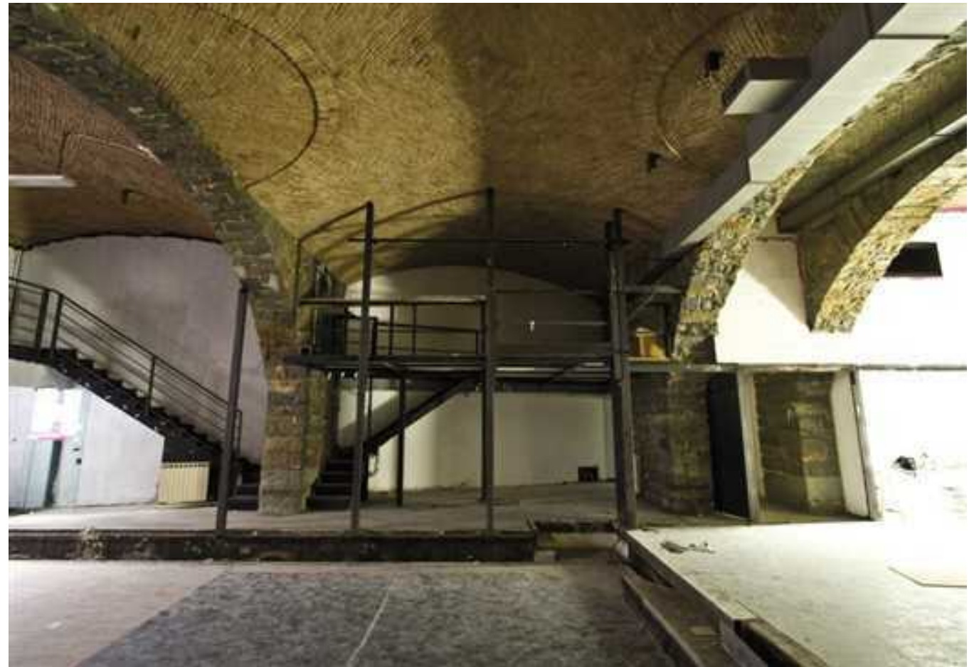
Cantiere HUB Trieste, foto di Albi Enesi
