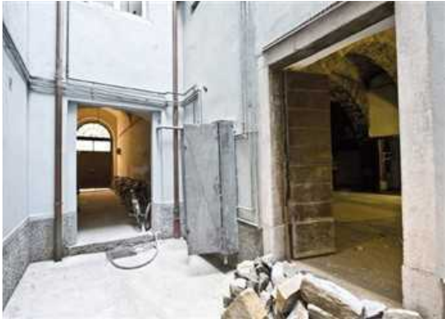
Cantiere HUB Trieste, foto di Albi Enesi
