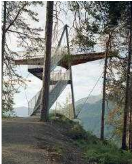
Corinna Menn, piattaforma panoramica in località Conn, presso Flims, 2006.
