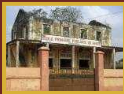
Restauro della Scuola di Ganvè - 2008
