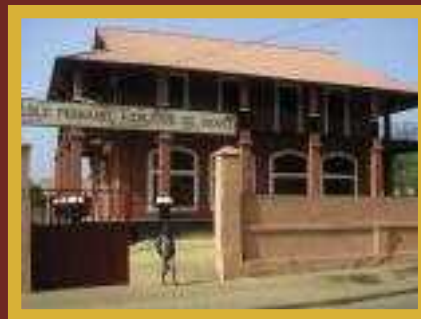
Restauro della Scuola di Ganvè - 2009
