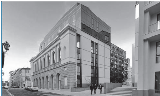
Firenze, ex Teatro Comunale: il "cubo nero" e la trasformazione dell'edificio
