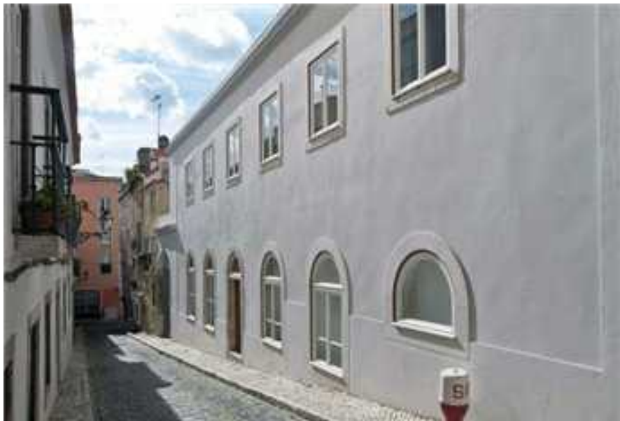
Vista della strada, ©Luísa Ferreira
