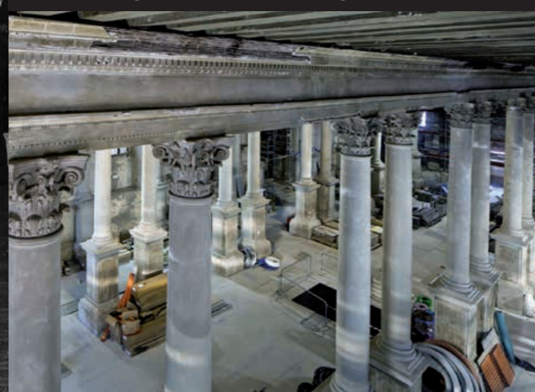
Sotto: Restauro del piano terra con vista dall'alto dei capitelli.
