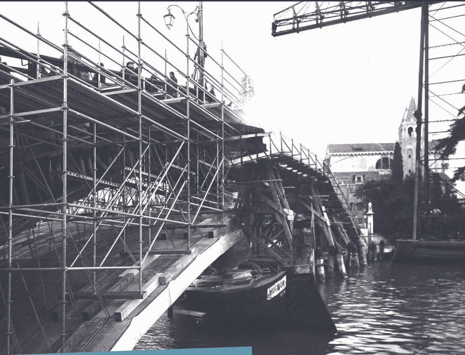
2017. Il cantiere per il restauro del Ponte dell'Accademia (a sinistra). 1933. Il cantiere per la costruzione del Ponte dell'Accademia (a destra).
