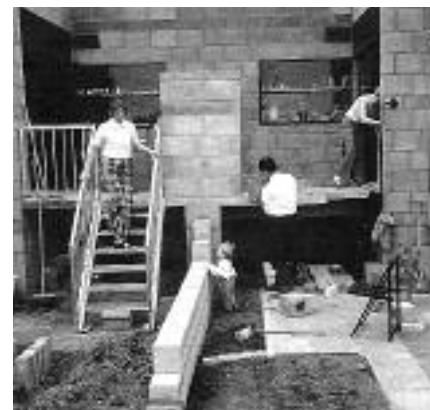
H. Hertzberger, Diagoon Houses, Delft. Vista delle terrazze
