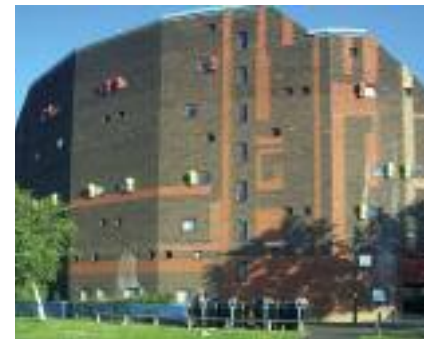
R. Erskine, Byker, Edificio The Wall, Newcastle-upon-Tyne. Fronte nord
