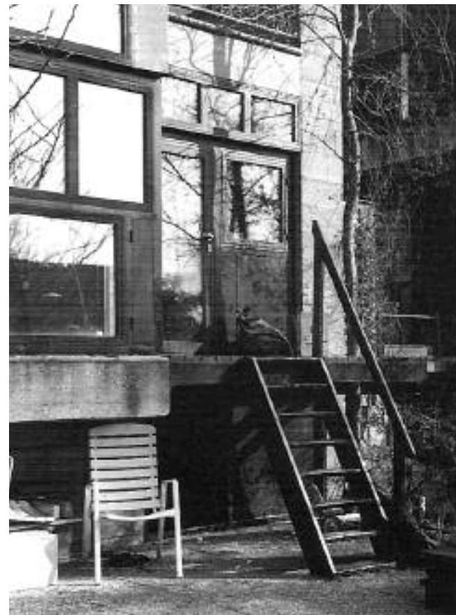
H. Hertzberger, Diagoon Houses, Delft. Dettaglio di un ingresso
