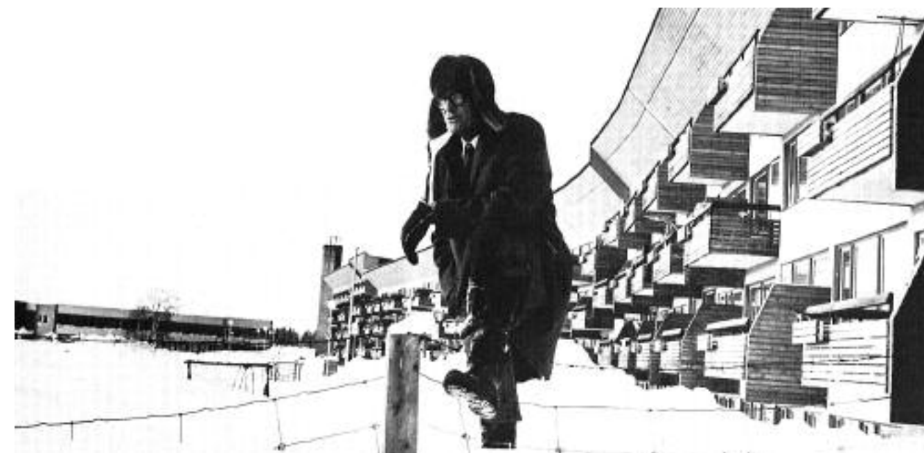
R. Erskine, Edificio The Wall, Svappaara. Fronte sud
