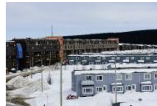
R. Erskine, Edificio The Wall, Resolute Bay. Fronte nord
