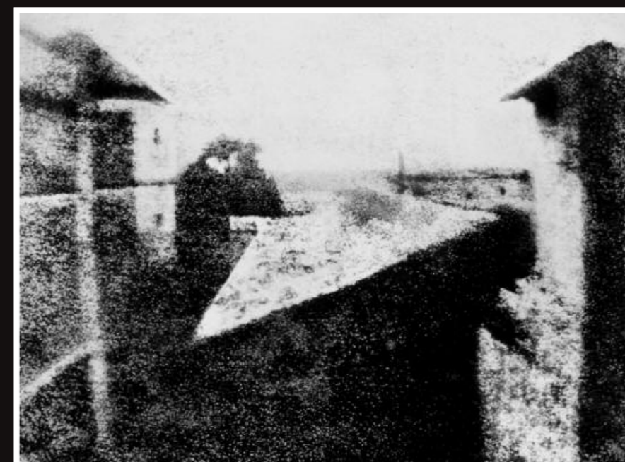
1. Point de vue, Maison du Gras, Chalon sur Saône, F - di Nicéphore Niepce a Saint Loup de Varennes, 1826.
