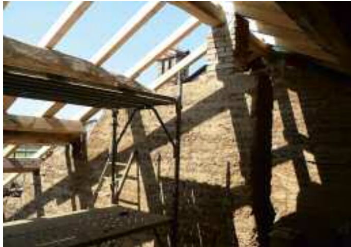
Ristrutturazione di cascina in terra battuta: rifacimento del tetto (Novi Ligure, Alessandria, I). Foto: G. Bollini, 2010
