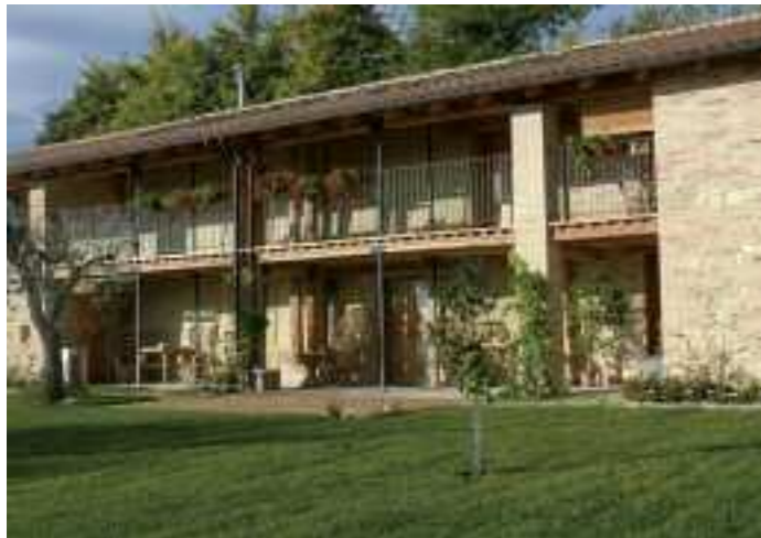
B&B Borgocapo: fine lavori (Casalincontrada, Chieti, I). Foto: S. Giardinelli, 2013
