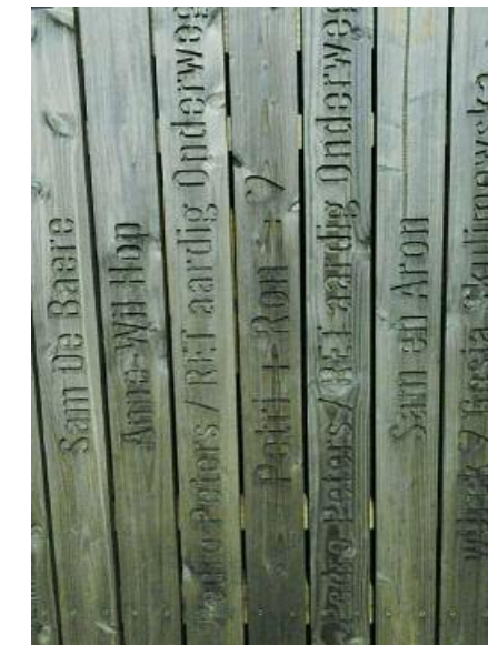
Quartiere di Luchtsingel, Rotterdam, Olanda. Passerella pedonale realizzata attraverso il progetto “I make Rotterdam, dettaglio delle assi personalizzate.
